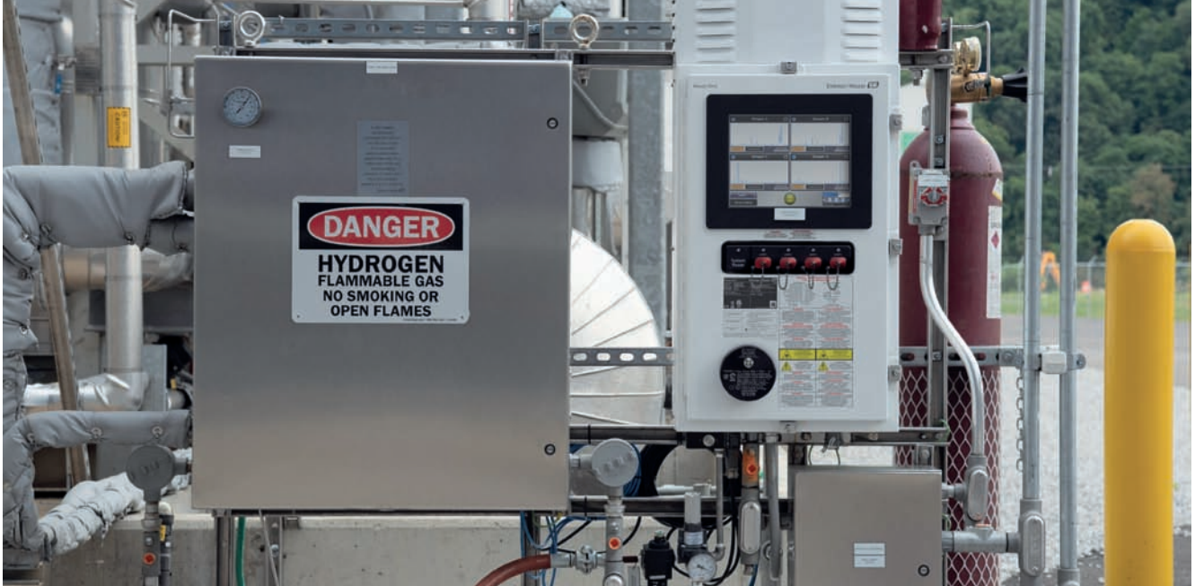
Raman analyzátor Rxn5 vyhodnocuje zmes obsahujúcu vodík.
