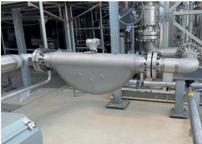
Ak sa bude zvyšovať objem vodíka vstrekaného do potrubia so zemným plynom, bude možné Coriolisov prietokomer Proline Promass F, ktorý sa používa za miestom vstrekovania vodíka, ľahko nahradiť prietokomerom Promass X s vyššou kapacitou, a to bez úpravy potrubia.
